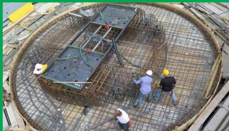
Der Sockel des Denkmals wurde mit Stahl der Feralpi-Gruppe realisiert.
