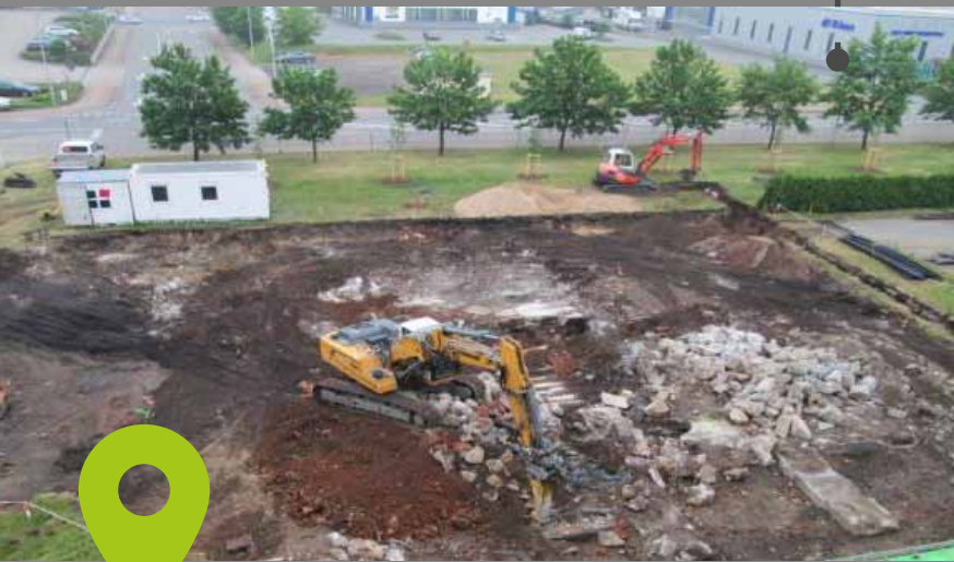
Alte Fundamente einer Generatoren-Station
