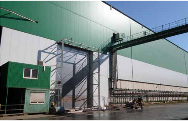
Weitere Schließung der Schrotthalle, Südseite (seit 2015)
