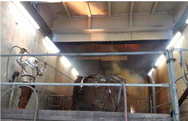
Neue Einhausung für Brennen Resteisen und Stahlbären mit Anschluss an Entstaubungsanlage im Fallwerk
