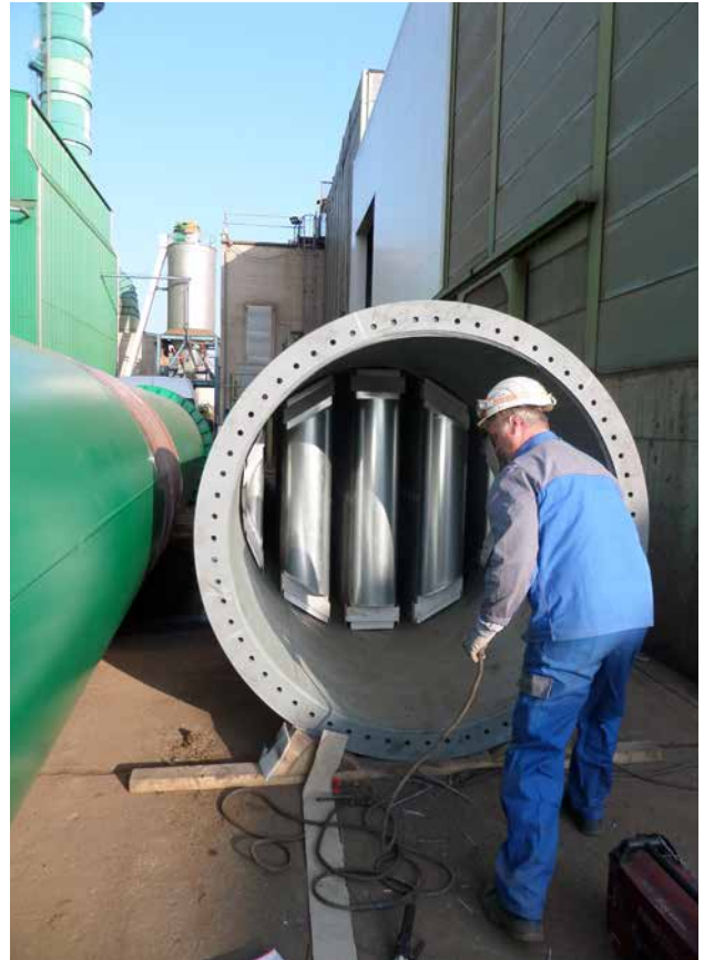
Einbau Schalldämpfer KondiratorKamin (2015)
