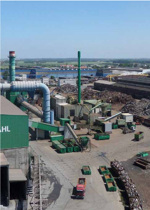
Einhausungen, Kapselungen und Emissionsminderungsmaßnahmen am Kondirator (2014 – 2016)
