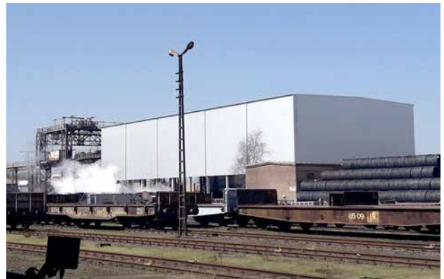
Neue Einhausung für Kippprozess und Abkühlung E-Ofenschlacke
