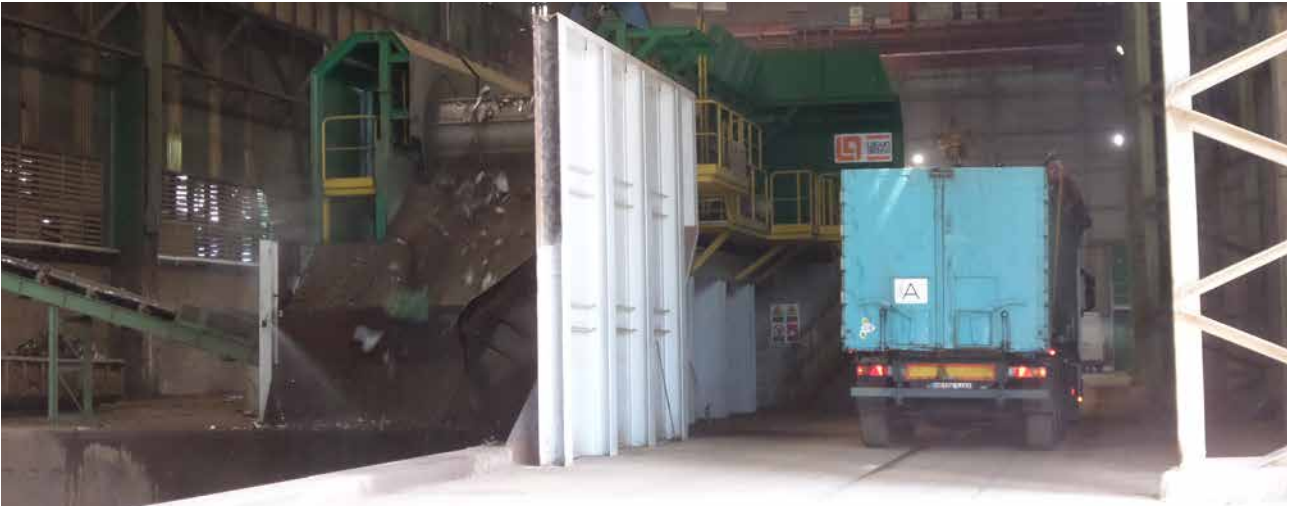
Schrottreinigungsanlage / Magnettrommel (seit 2015)
