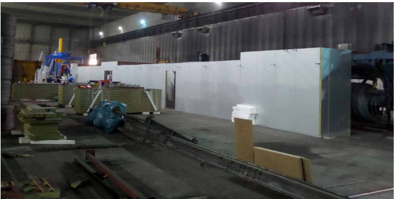
Kapselung Reckanlagen, Drahhalle EDF (seit 2015)
