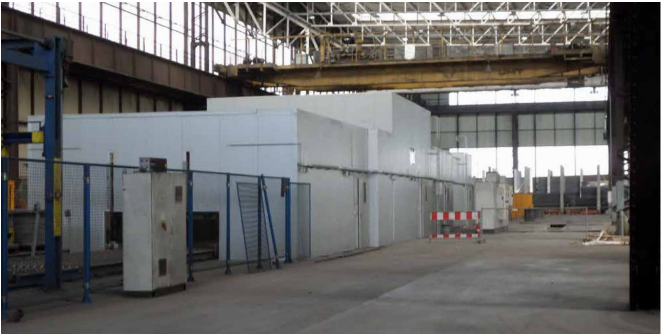
Kapselung Mattenschweißmaschine, Mattenhalle EDF (seit 2015)
