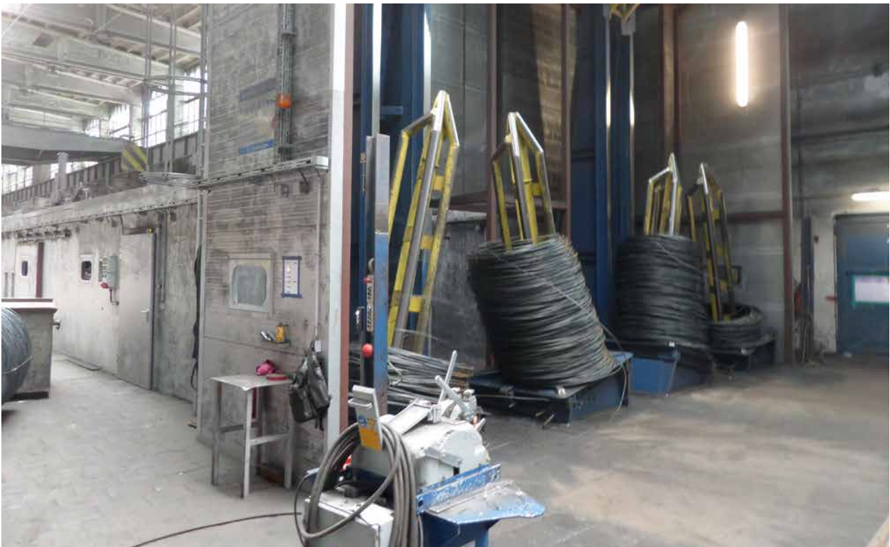
Kapselung der Drahtzuganlagen, Mattenhalle EDF (seit 2015)
