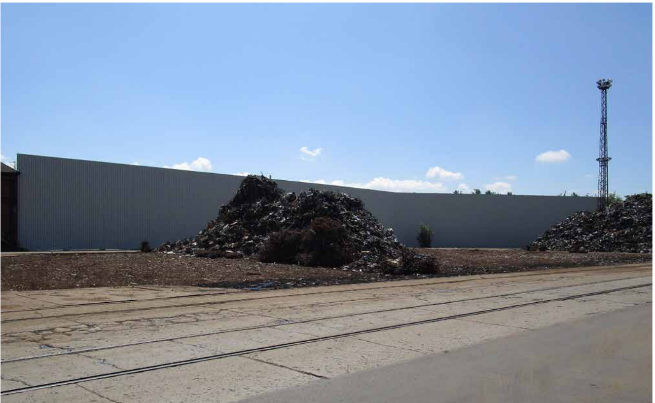
2016 neu errichtete Schallschutzwand am Schrottlager 4/5
