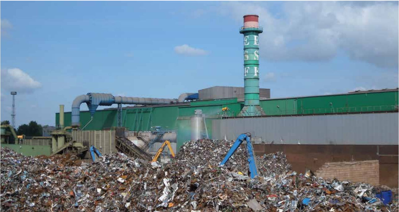
Darstellung der zweiten Entstaubungsanlage (seit 2006) mit Sammelleitung, Horizontalzyklon, Filterhaus, Kamin und Staubsilo, im Vordergrund die Kondiratoranlage
