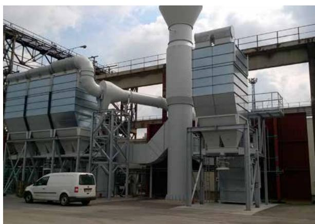
Neue Entstaubungsanlage im Fallwerk
