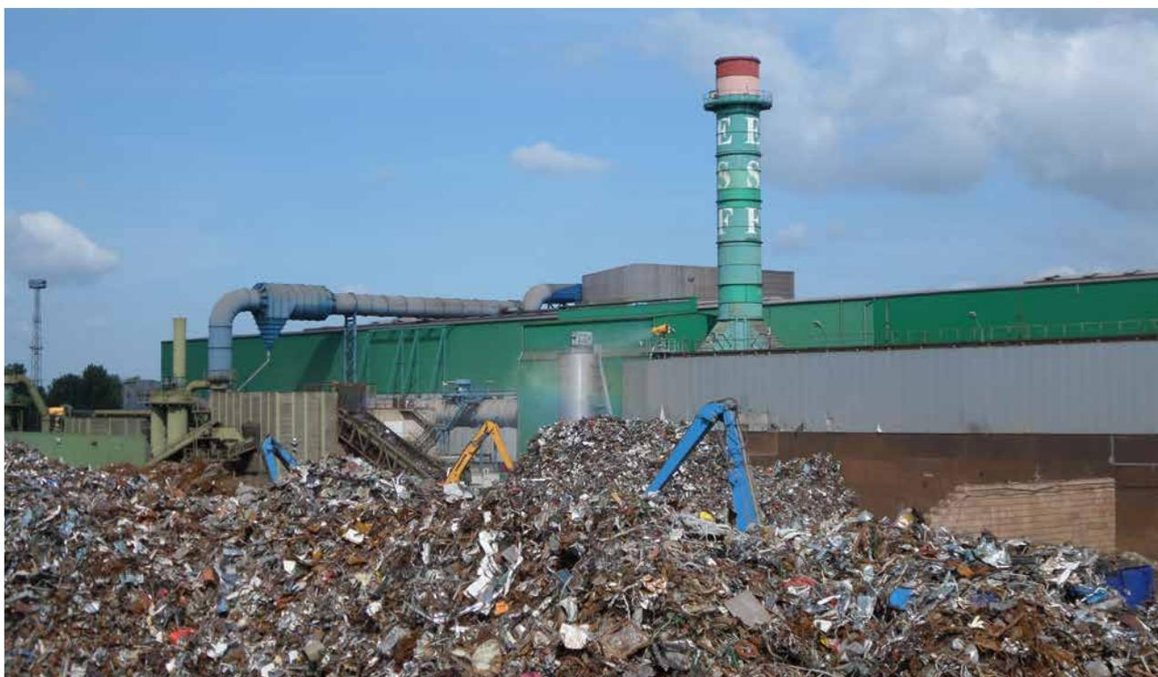
Darstellung der neuen zweiten Entstaubungsanlage mit Sammelleitung, Horizontalzyklon, Filterhaus, Kamin und Staubsilo:
