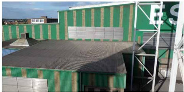
Austausch und Einbau von Zu- und Ablüftern im Dachbereich sowie in den Ost- und Westgiebel des Stahl- und Walzwerkes (seit 2014)
