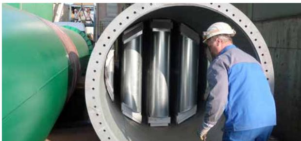
Einbau Schalldämpfer KondiratorKamin (2015)
