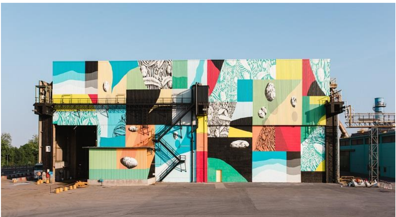
La facciata dello stabilimento di Acciaierie di Calvisano con il murale realizzato in occasione dei 50 anni dell'azienda
