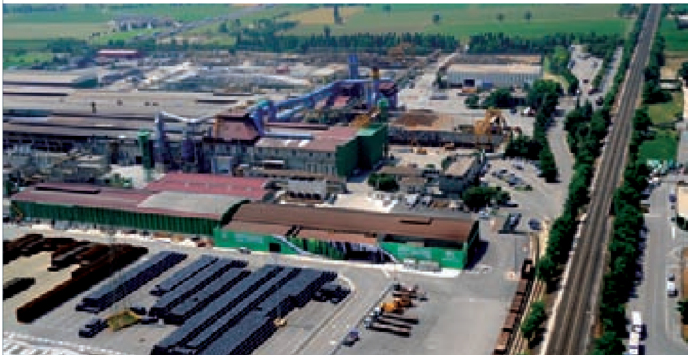
Fig. 26 L'area dello stabilimento di Feralpi a Lonato del Garda
